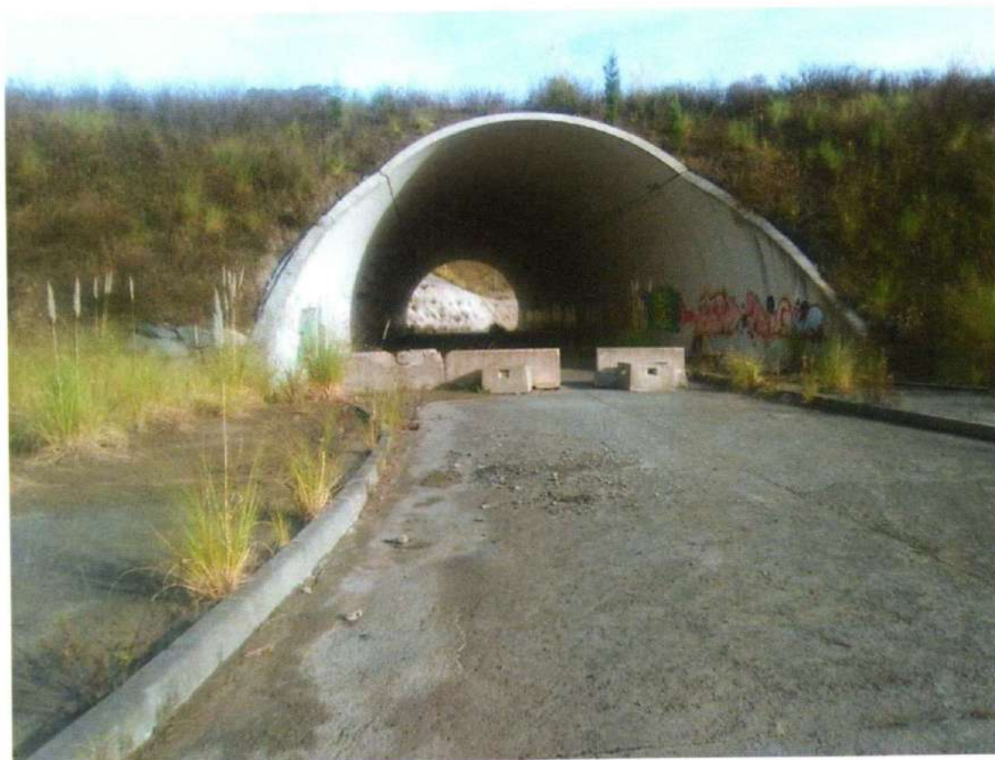
Imagen: Vista Falso Tunel en fase accesos
